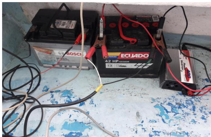
Fotografía 4.- Banco de alimentación de energía para los equipos.
